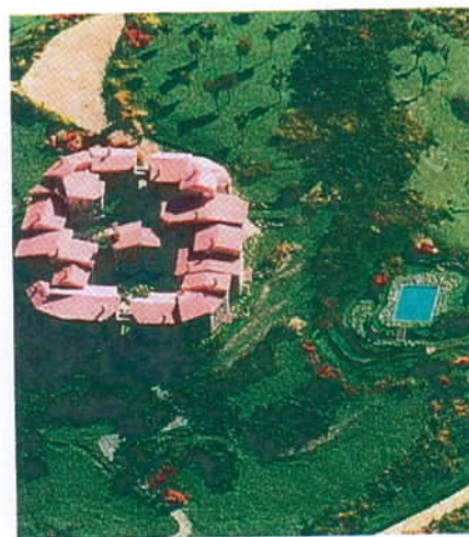
"BYEN" SETT FRA OVEN: Leilighetene, 18 i tallet, omkranser det 19. frittstående huset som tidligere var kirken.
